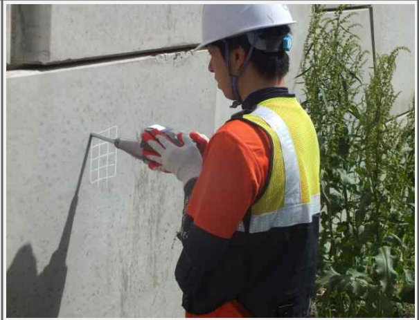
콘크리트 패널 반발경도조사
