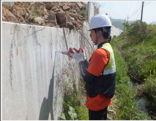
콘크리트 패널 반발경도조사
